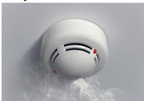
Автоматически при реагировании тепловых, дымовых, оптических датчиков системы на факторы, присущие загоранию или пожару - выделение тепла, появление дыма, появление пламени
