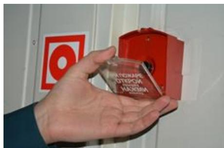
Ручным включением работником при обнаружении пожара или признаков пожара.
